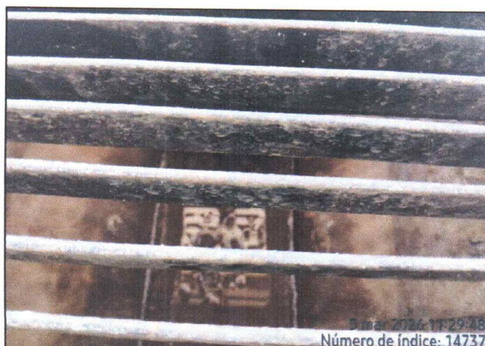
Fotografía N°31: Inspección de tapas de cajas del sistema de desagüe.
