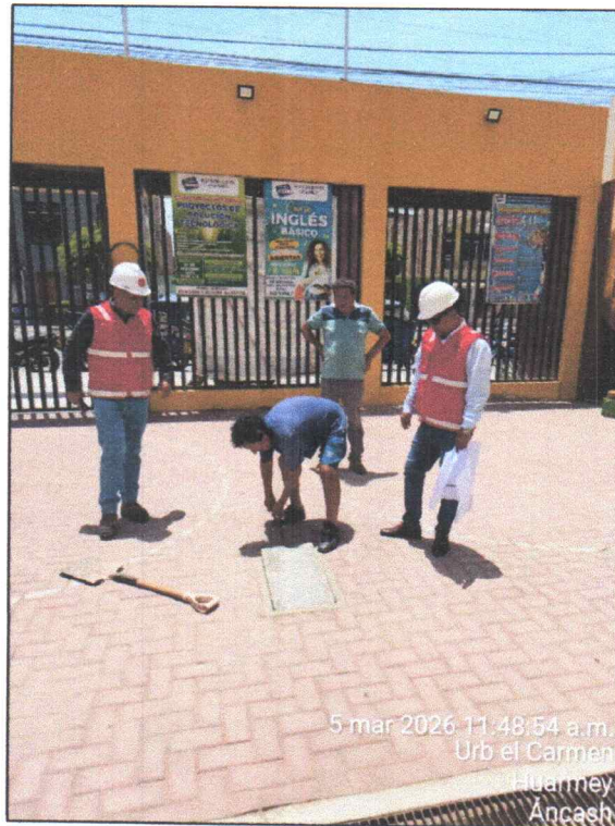
Fotografía N°28: Inspección de tapas de cajas del sistema de desagüe con apoyo de personal del IESTP Huarmey.
