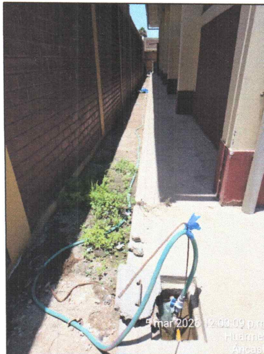
Fotografía N°21: Instalación de agua alterna de parte de la institución de manera provisional no adecuada.
