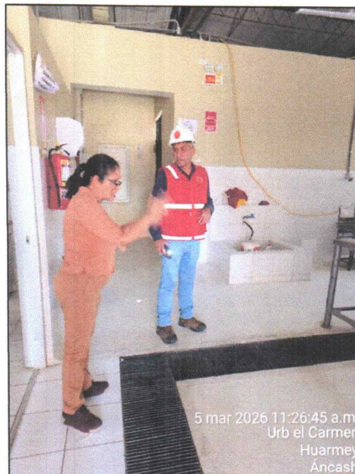
Fotografía N°23: Taller donde se inicia la descarga de efluentes al sistema de desagüe.
