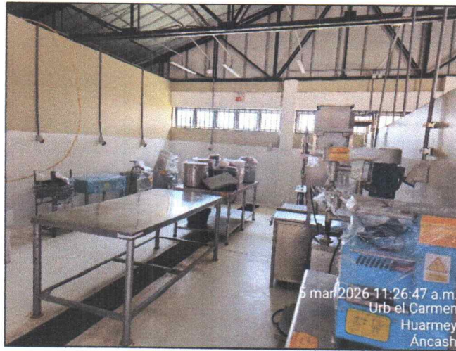
Fotografía N°07: Verificación de instalación de equipos eléctricos en talleres.
