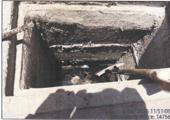
Fotografía N°33: Inspección de tapas de cajas del sistema de desagüe.
