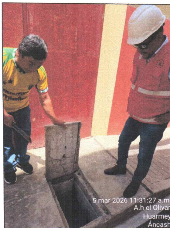
Fotografía N°25: Inspección de tapas de cajas del sistema de desagüe y se observa que están con presencia de agua estancada debido a la falta de pendiente para su circulación.
