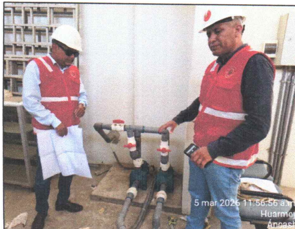
Fotografía N°10: Verificación de instalación de bombas en tanque elevado.
