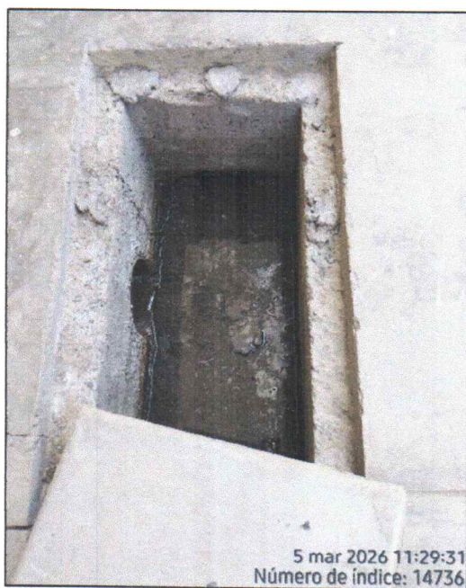
Fotografía N°30: Inspección de tapas de cajas del sistema de desagüe.
