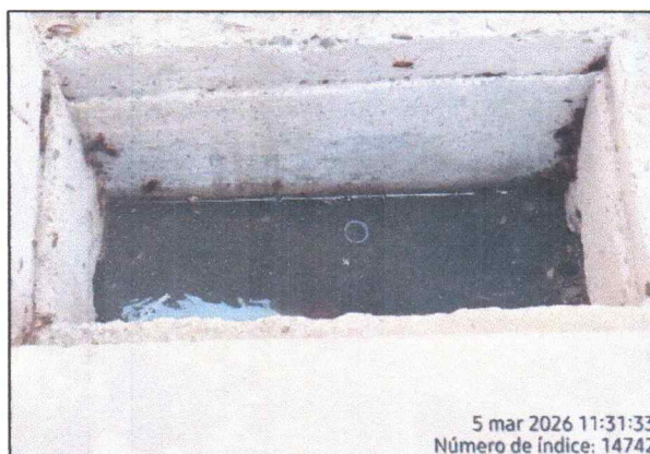
Fotografía N°32: Inspección de tapas de cajas del sistema de desagüe con presencia de agua estancada lo que dificulta la circulación a la red pública.
