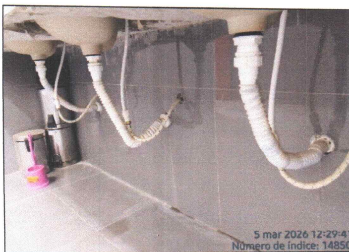
Fotografía N°17: Instalación deficiente en griferías tanto de agua como de desagüe en los servicios higiénicos de los tres niveles del bloque de aulas.
