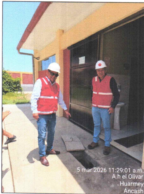
Fotografía N°24: Inicio de descarga de efluentes al sistema de desagüe, los cuales no cuentan con un tratamiento previo ni presencia de trampas de grasa a fin de retener sólidos.
