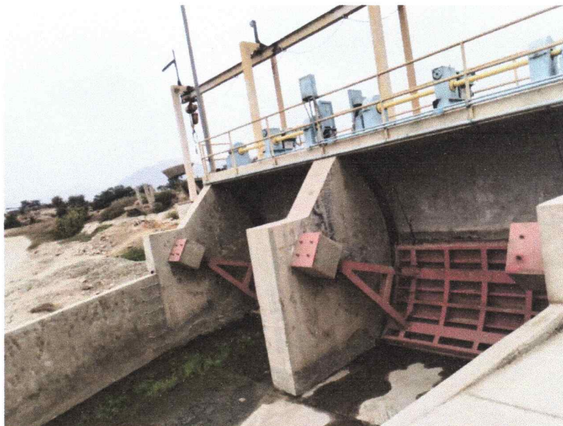
Fotografía N°03: Inspección de la infraestructura del Dren Cascajal
