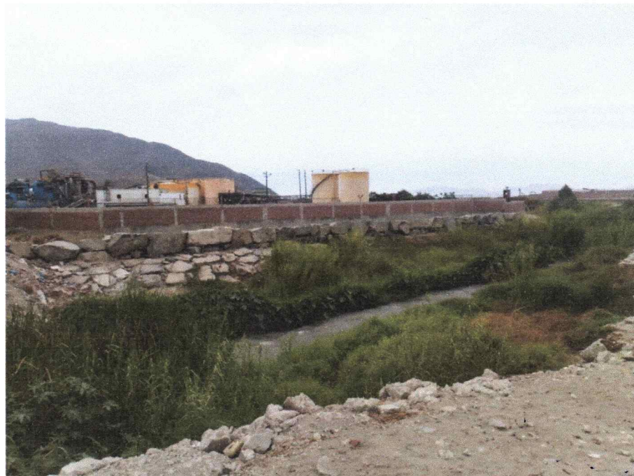
Fotografía N°05: Inspección de la infraestructura del Dren Cascajal, Ubicación: 17 L Este 761738.66, Norte 9002789.72
