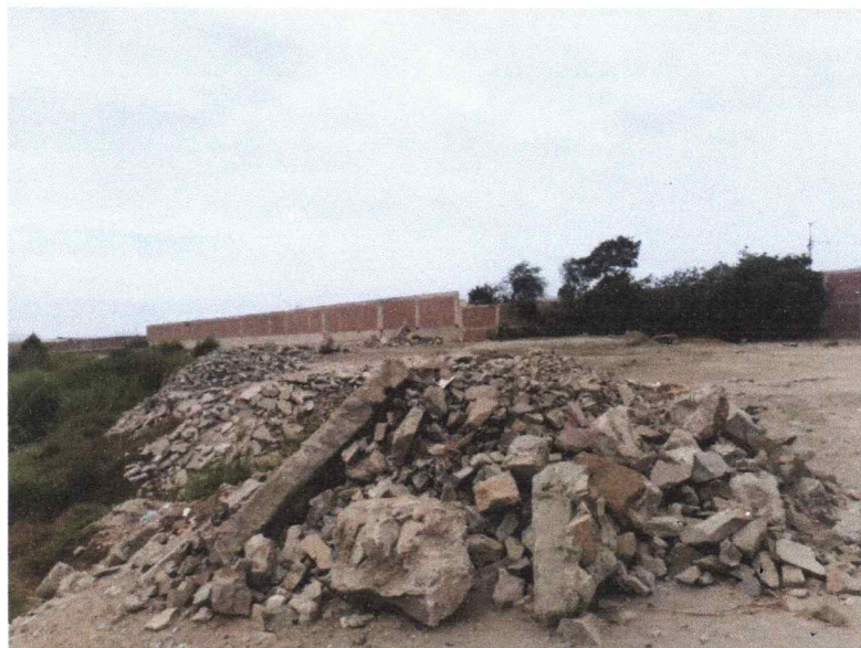
Fotografía N°06: Inspección de la infraestructura del Dren Cascajal, Ubicación: 17 L Este 761738.66, Norte 9002789.72
