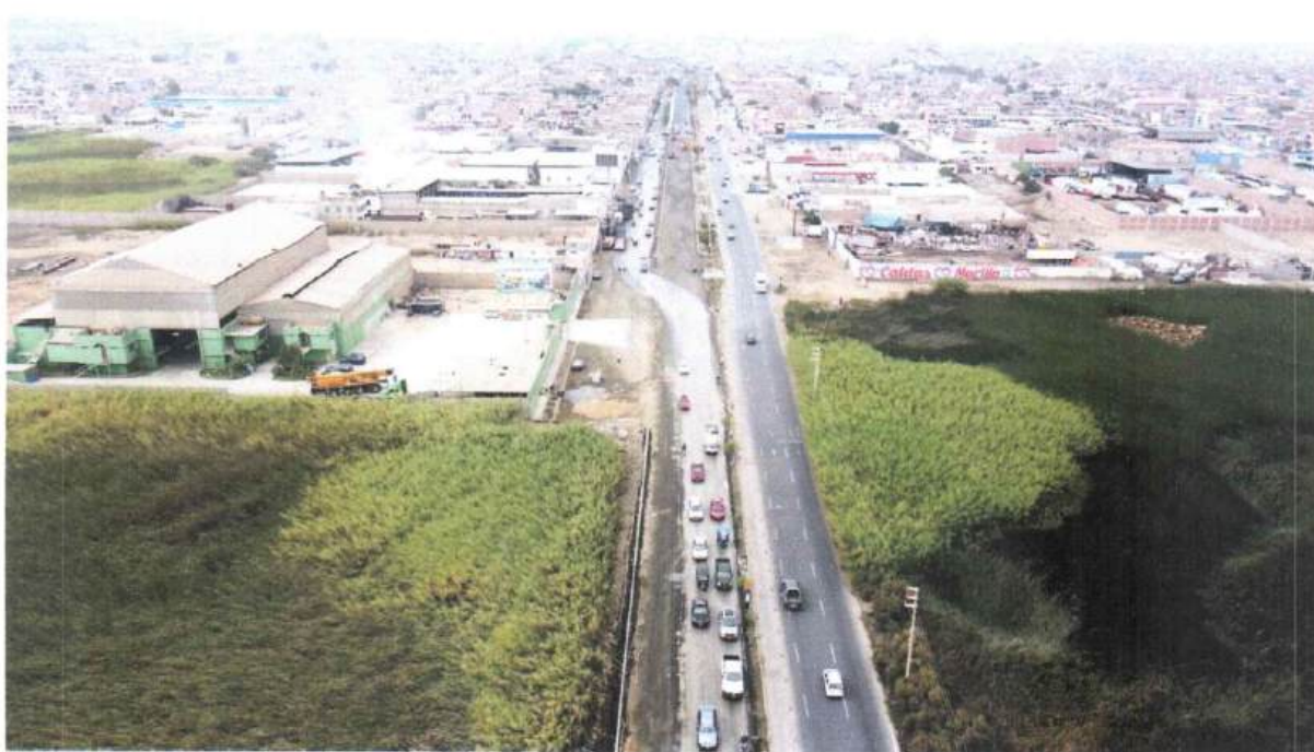
Fotografía N°01: Vista panorámica de la obra en ejecución.
