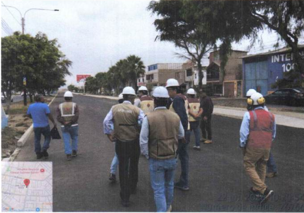
Fotografía N°02: Inicio de la Inspección con la presencia de los dirigentes vecinales.
