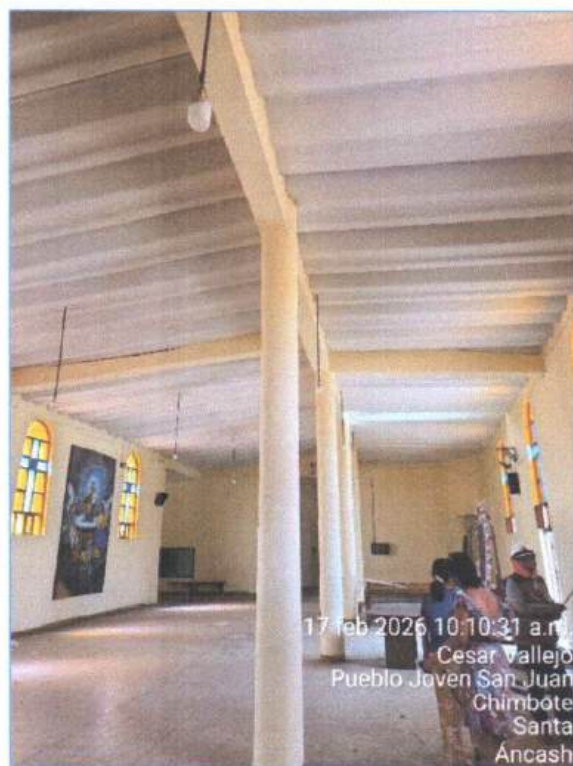
Fotografía N°08: actualmente la parroquia se encuentra en condición no habitable.
