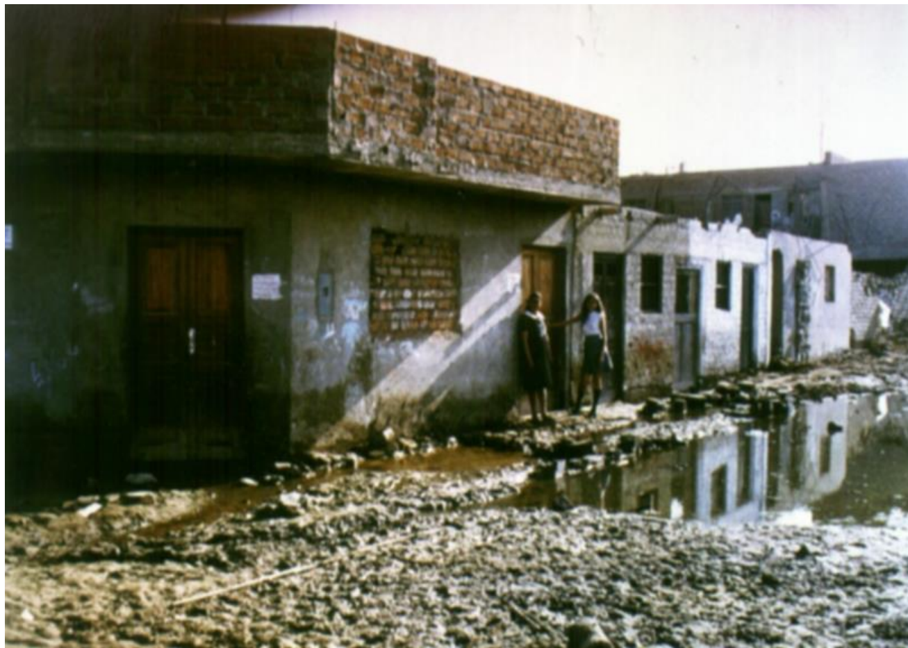
Fig. 9. Inundación de área residencial en el sureste de Chicla debido al asentamiento y compactación del terreno.
