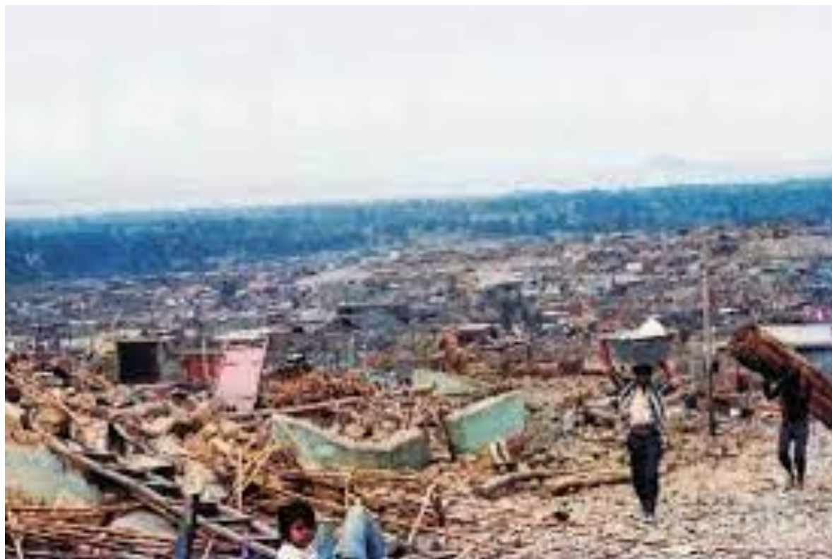
Fig. 6. Casas de adobe destruidas en Chimbote, en zonas de depósitos eólicos
